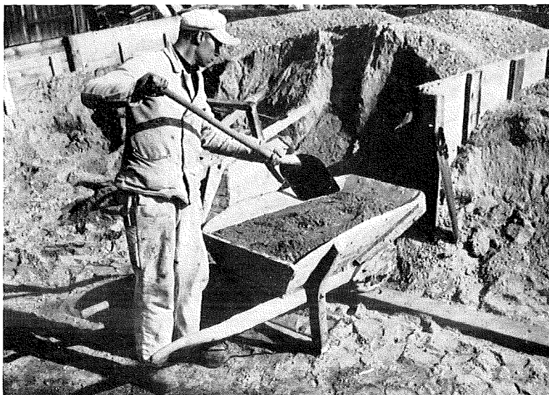
Fig. 30. Trillebør til afmåling af materialer. Den er forsynet med lister, som angiver hvortil børen skal fyldes.
